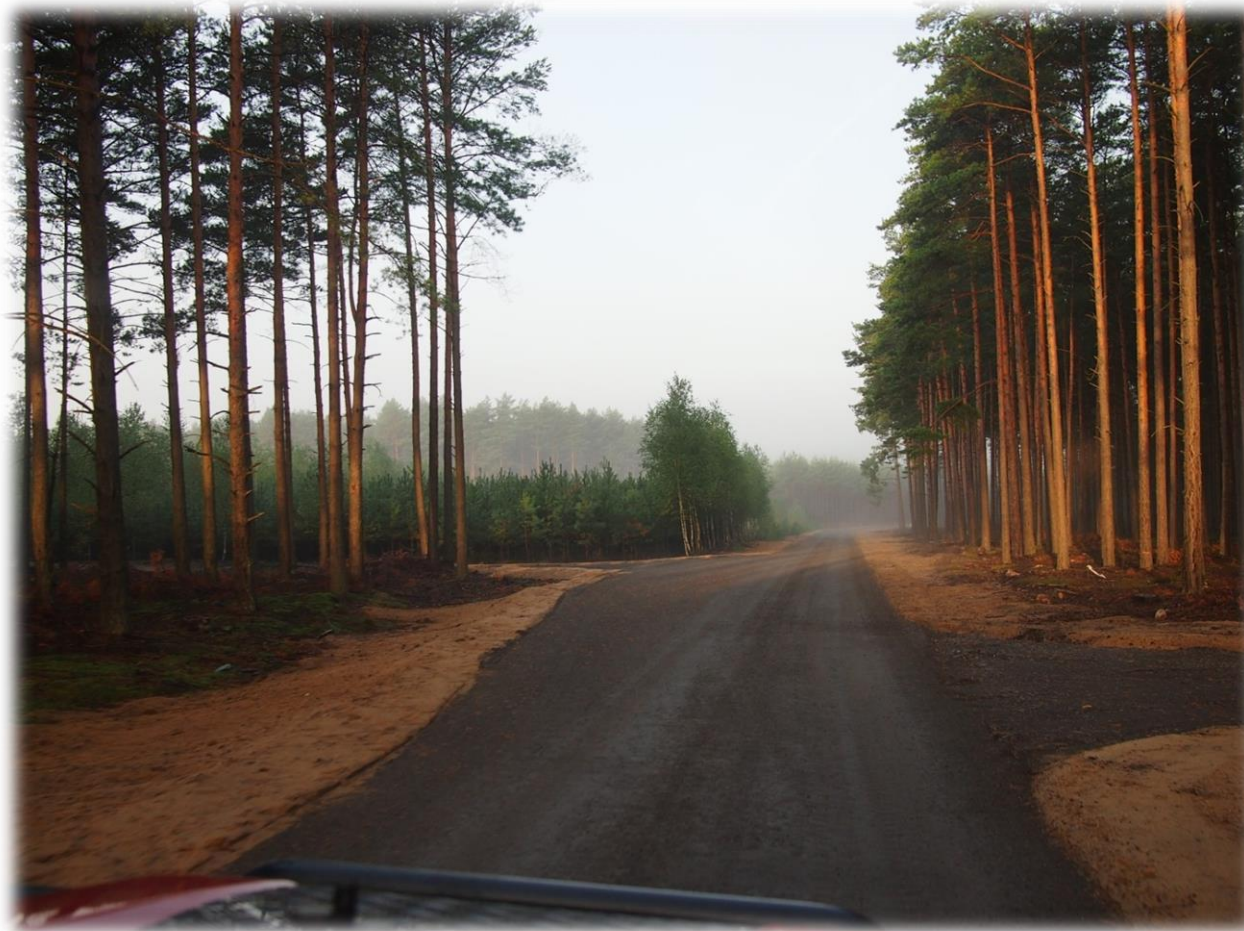
Dojazd pożarowy nr 9
