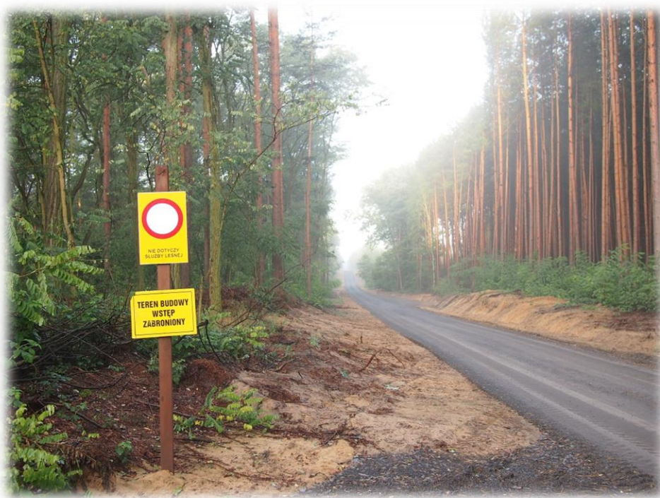
Dojazd pożarowy nr 9
